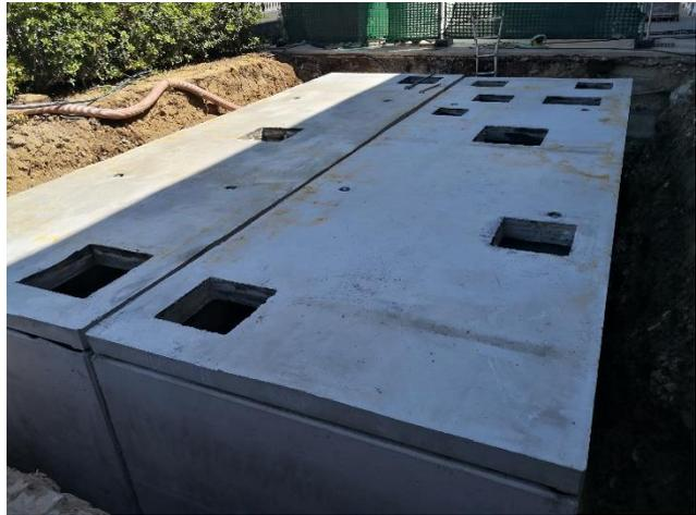
*Fig 6 rappresentazione fotografica vasche monoblocco con copertura separata cantiere AgriDep.*
