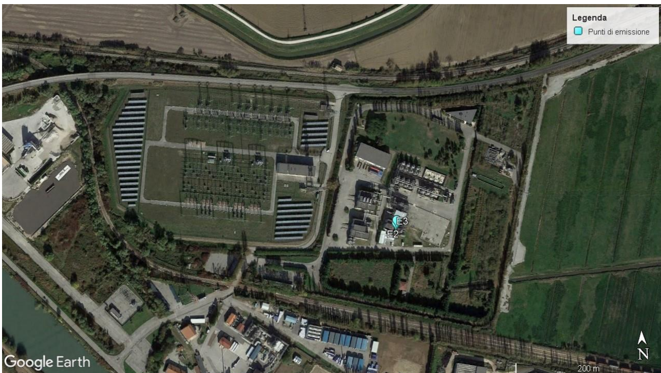
Figura 2.1 Localizzazione del nuovo punto di emissione – Centrali termiche (Vista aerea – Fonte Google Earth)
